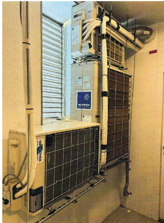
Figuren 2 en 3 Door brandweer aangetroffen airco buitenunits in niet-besloten ruimten voor het veiligheidstrappenhuis.
